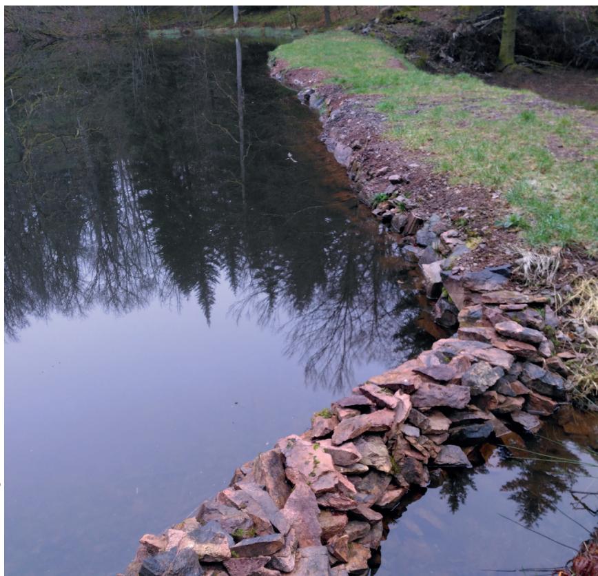
Couronne de pierres sèches formant un déversoir traditionnel.
